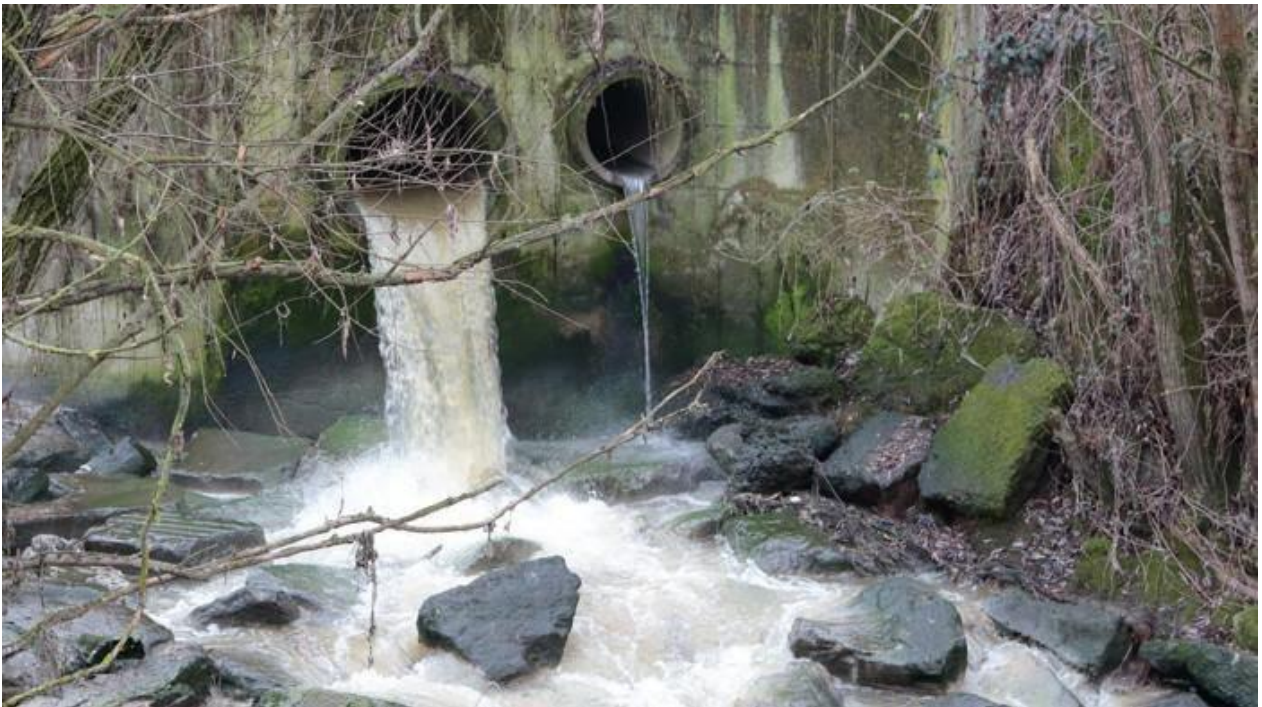
Scarico a norma di legge, acque non trattate in deroga (da: La Stampa Online del 6 gennaio 2016)
