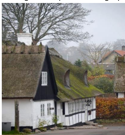
Figura 4.7 Casa con tetto verde alla maniera dei Vichinghi, a Roskilde in Danimarca (Foto di E.A. Fano)
